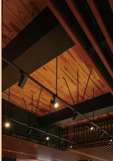
<MIデッキ> 既存のRC造/S造の建築物の天井に「木空間」を実現する型枠材兼仕上材
